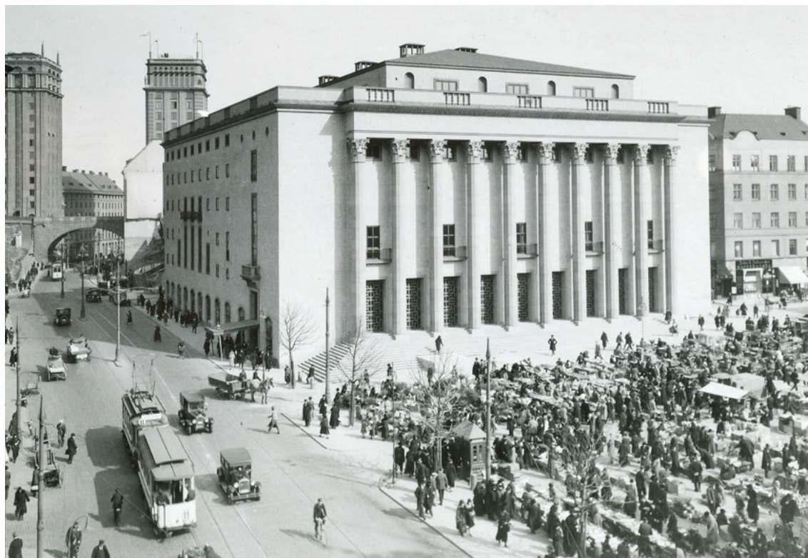
FIGUR 2. Hötorget var länge en lantligt präglad handelsplats i staden. Med dragningen av Kungsgatan på 1910-talet knöts torget tydligare till stadslivet. Konserthusets tempelliknande byggnad bröt tydligt mot folklivet och den brokiga torghandeln, men denna kontrast kom under 1920-talet alltmer att uppfattas som en särskild urban kvalitet. FOTO: Stockholms stadsmuseum.
